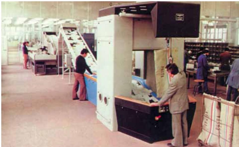
La macchina per la depolverizzazione nell'impianto CMP di Torino. In questa fase viene eseguita una prima cernita delle corrispondenze non normalizzate
