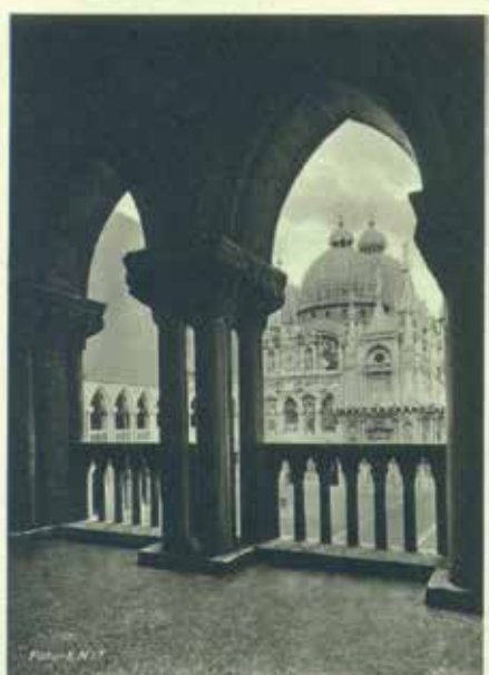
VENEZIA — Basilica di San Marco dalle Logge interne del Palazzo Ducale.
